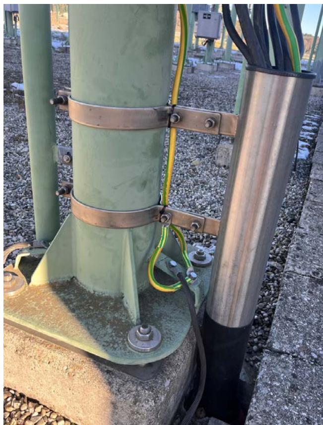
Slika 4: Primer montaže objemke \Phi 219,1 mm
