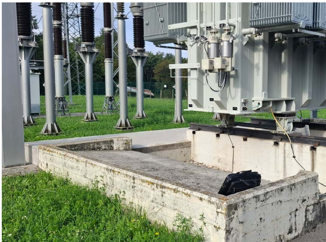
Slika 2: Situacija lovilne sklede pod konzervatorjem TR 1.
